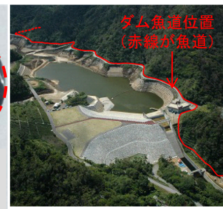
ダム周りの魚道設置による 甲殻動物の移動路確保事例
