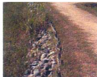
自然材料を用いたため池護岸
