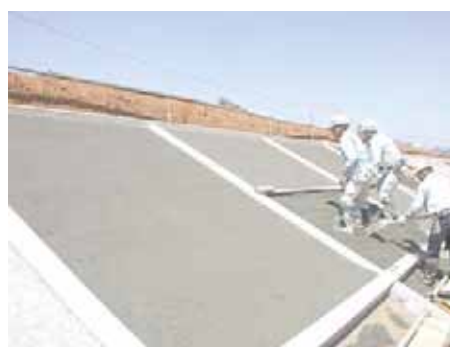
② 透水コンクリート打設
