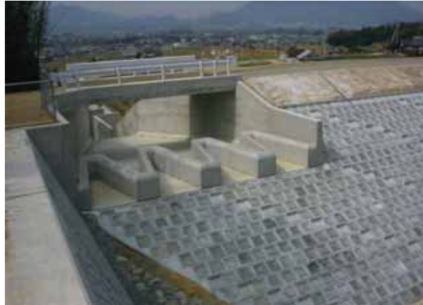
ラビリンス堰（鉄筋コンクリート）
