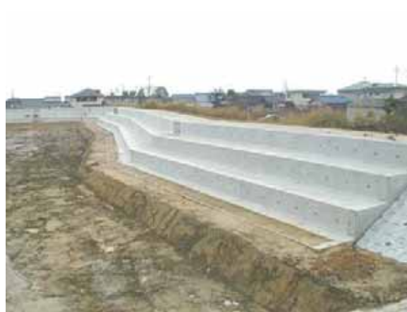
⑤ 施工完了
