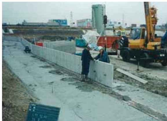
③ 型枠設置
