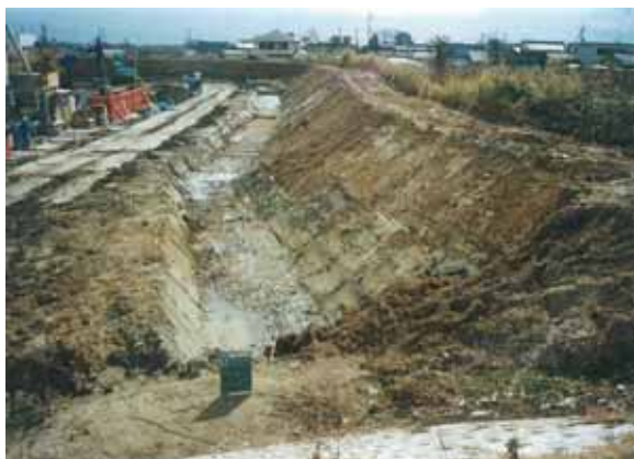
① 掘削完了（打設前）
