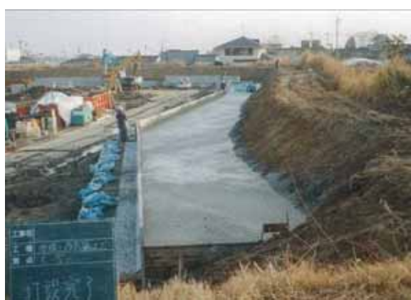
④ 固化処理土打設
