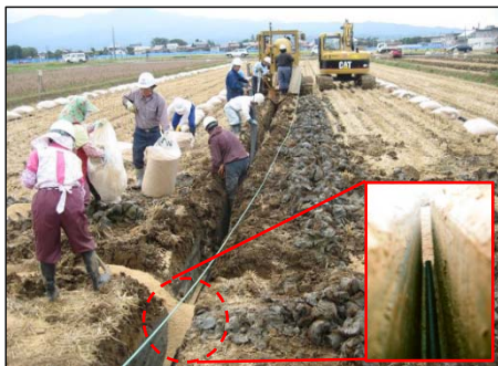
本暗渠の施工状況
