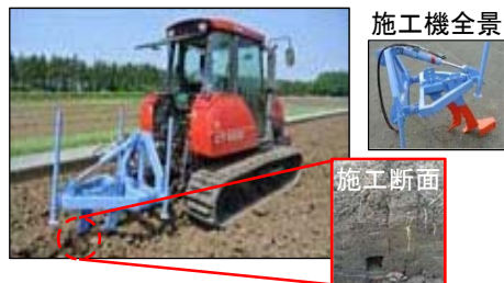
【従来工法よりも耐久性の高い補助暗渠を施工】
