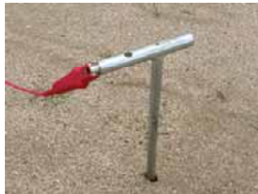
補助接地棒打込み状況
