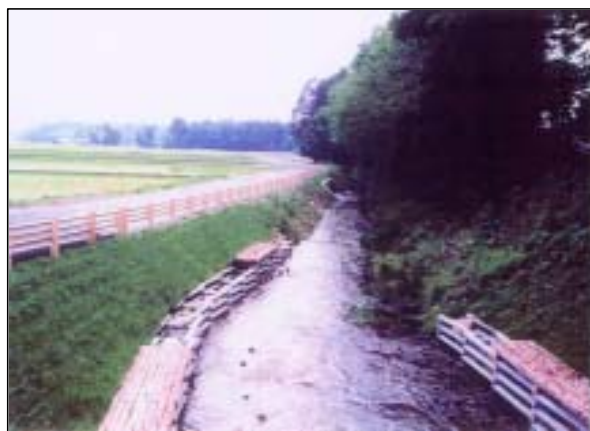
【井桁沈床工による生息場所の確保】
