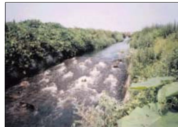
【魚の移動に配慮した急流工】
