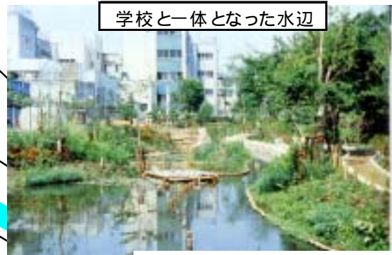
学校と水路の境界にあったブロック塀とネットフェンスをはずし、玉石積みと生け垣に
