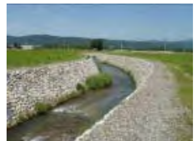
整備後3年目の状況 (多様な流れにより魚類の生息環境の質が向上している。)
