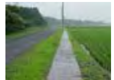
蓋が設置された水路
