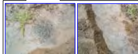
小水路の拡大写真
