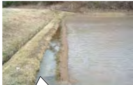
小水路の設置状況
