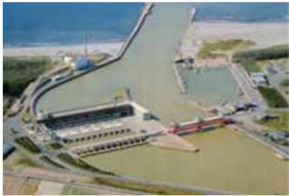
国営施工(新川排水機場) (国営新川農業水利事業にて整備)
