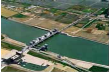
(国営施工)頭首工
