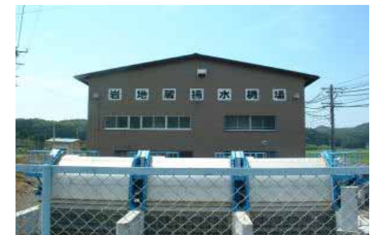
土地改良区が管理する揚水機場
