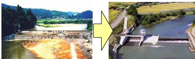
老朽化した頭首工の改修
