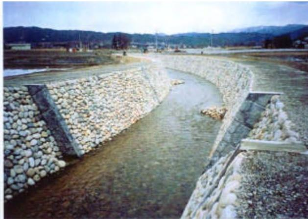
護岸構造は、アンカー付空積み工法を採用水路底部に水制工を設け、生物の棲む場所の多様性を確保。
