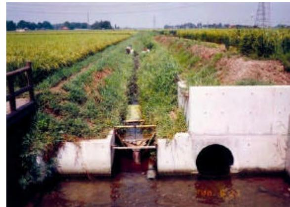
水路の一路線を2段構造とし、魚の水路と水田の移動を確保
