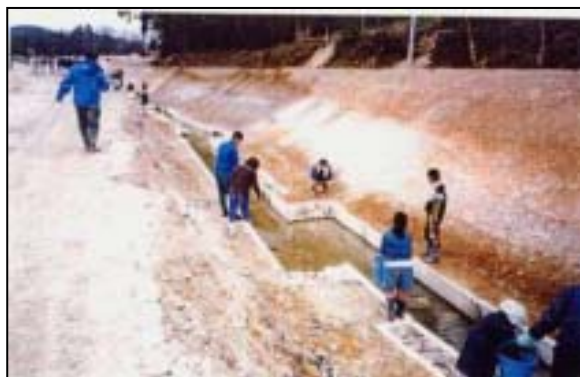
排水路を屈曲させ、よどみ等を作り、 魚類等の生息・繁殖・避難場所を確保した例
