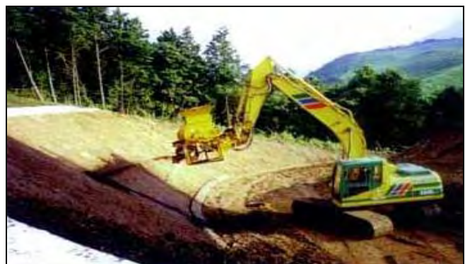
緑化基盤材吹付施工状況
