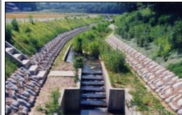
階段式の落差工とすることで、魚類等の 生息環境間の移動を可能とした例
