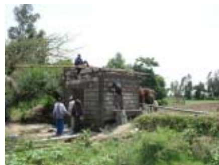
農民によるポンプ小屋の建設 (プログラム II)
