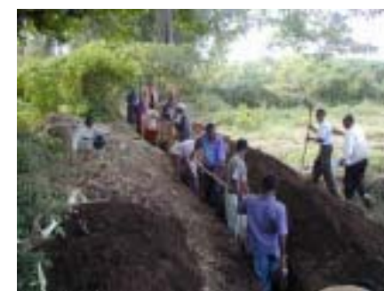
農民参加による水路掘削 (プログラム II)
