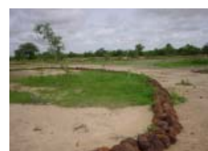
現地資材を有効利用し、ストーンラインを構築、土砂流亡を防止
