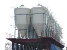
例:TMRセンターに飼料用米保管タンクを増設
