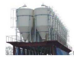
例:TMRセンターに飼料用米保管タンクを増設
