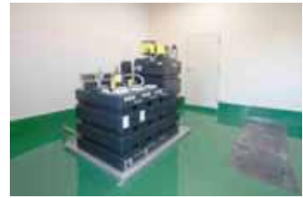
PH処理装置・油水分離槽
