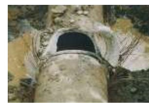
破裂したパイプライン
