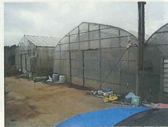
写真5 Fハウス外観
