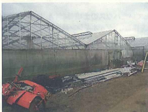
写真1 Aハウス外観
