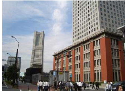
横浜第2合同庁舎(右側建物)
