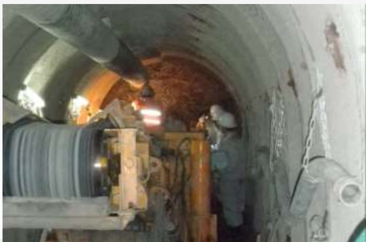
地下水排水トンネル切羽での地質調査 (山形県鶴岡市・七五三掛地すべり防止区域)
