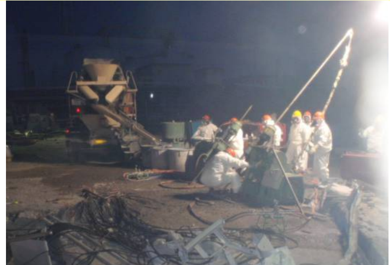
凝固剤注入による止水対策
