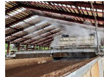
堆肥自動攪拌機
