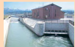
農業水利施設を活用した小水力発電
