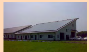
農業関連施設に設置した太陽光発電
