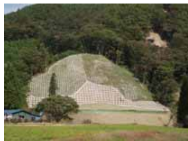
岩手・宮城内陸地震からの復旧 (上) 栗駒ダム下流の崩壊地(復旧前) (下) 栗駒ダム下流の山腹工(復旧後)
