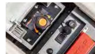
カバー内部の様子
