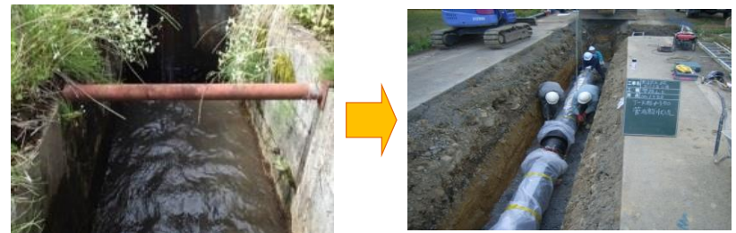
水路の更新(開水路→パイプライン)
