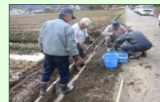
水路の補修 (施設の長寿命化)
