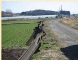
地震により受台から落下した水路
