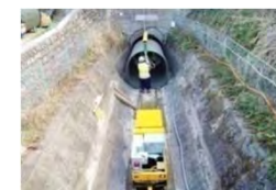
(例) 既製管挿入工法
