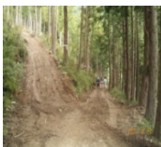
作業道・作業路の作設
