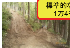
作業道・作業路の作設
