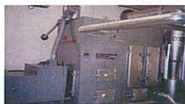
公共施設のボイラーの改良
