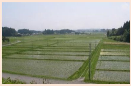
【基盤整備事業実施後の農地】
