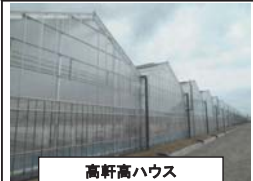
高軒高ハウス
