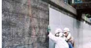
パネルを用いた用水路の補修の例
