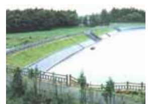
改修された老朽ため池
