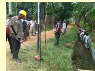
水路の維持管理
