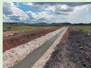
整備後の水路
