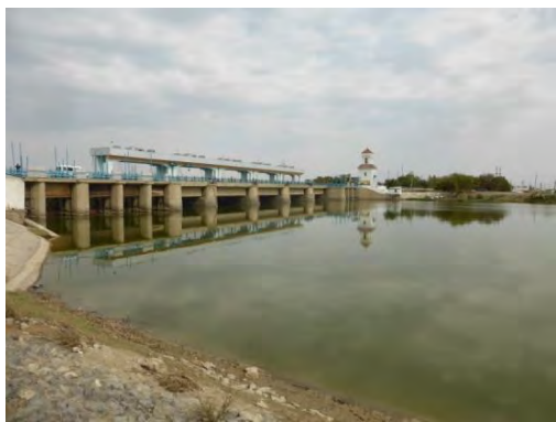
シルダリア川の橋梁の農業用水の取水口
