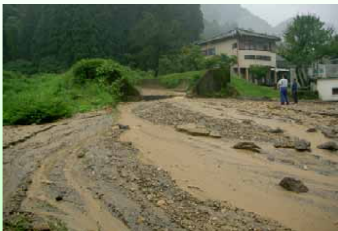
山腹崩壊により排水路が埋没
