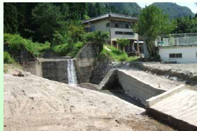
土砂撤去により排水機能回復
