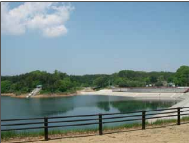
上流よりため池堤体を望む
