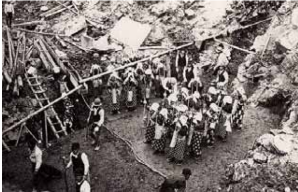
女人夫による搗き固め作業
