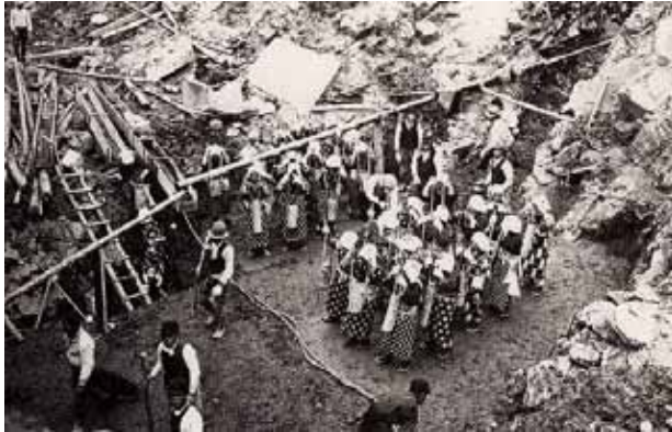
女人夫による搗き固め作業
