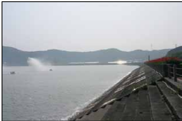
池の護岸の様子
