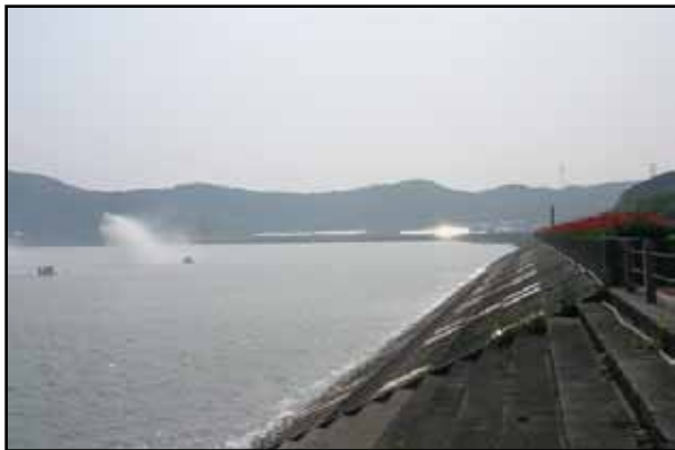
池の護岸の様子
