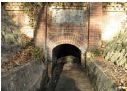
レンガ造りの 導水路
