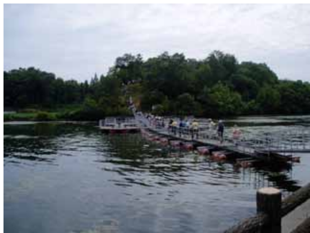
山大寺池の浮き棧橋
