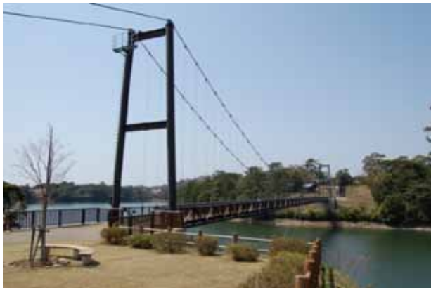
ため池内の吊り橋
