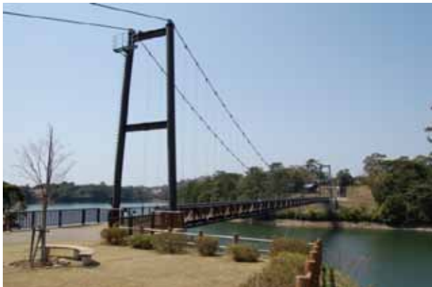
ため池内の吊り橋
