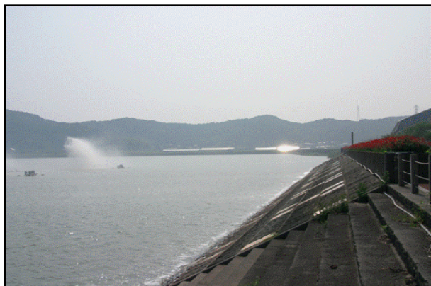
池の護岸の様子
