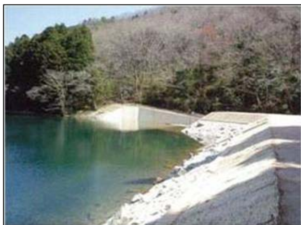
制波工には工事現場で出た自然石を埋め込んでいる。
