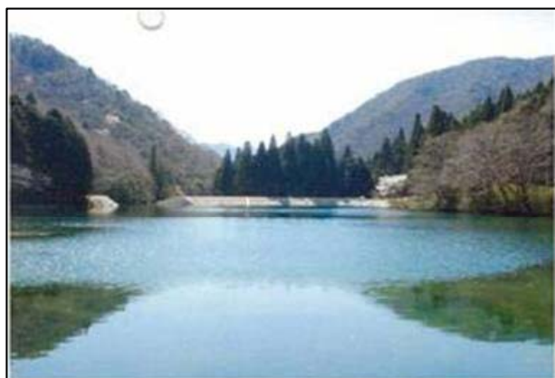
上流側より見た堤体・洪水吐
