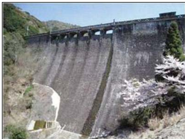
下流から見た堤体 直線重力式粗石モルタル工法
