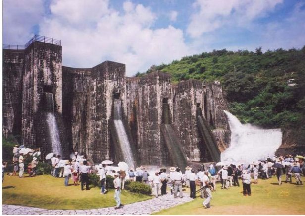
ユル抜き状況
