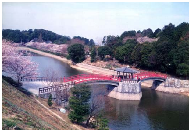
亀島にかかる橋
