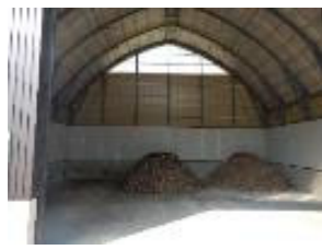
ジビエ処理施設からの残渣を減容化施設で処理。
