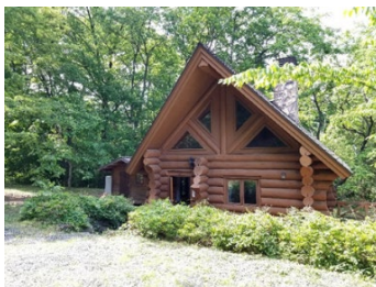
空き家を改修した宿泊施設
