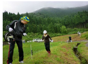
いのしし電気柵の設置
