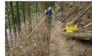
ミツマタ群生地遊歩道整備
