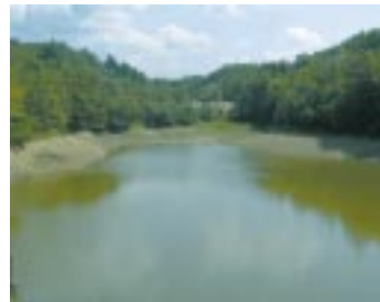
護岸工事を実施しないため池
