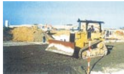
農道の工事状況
