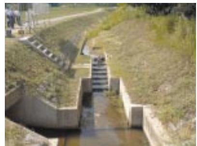
写真：配慮対策実施箇所
