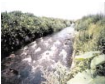
落差工改修の際に、上下流の連続性確保
