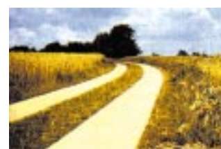
わだち舗装の例 わだちのみの部分舗装による緑のネットワークづくり
